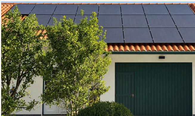
Garagem e painéis solares no telhado
