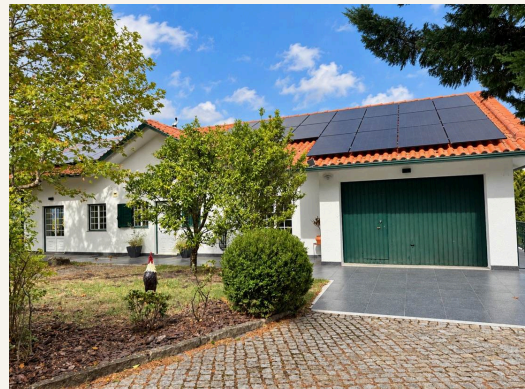
Casa e garagem com painéis solares
